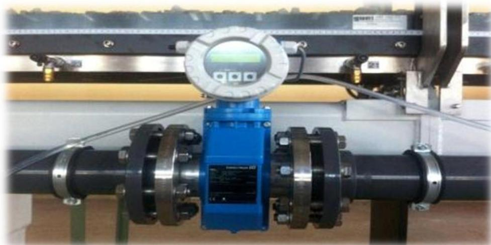
**Figure III.5 :** Débitmètre électromagnétique
