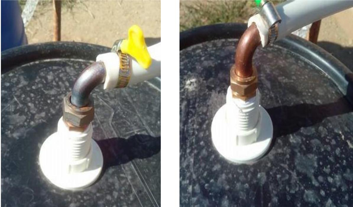
**Figure .IV.21** : différence de couleur en niveau de coude due à l'échappement de biogaz
