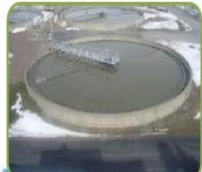
**Figure V.1 :** Décanteur primaire d'une STEP à boues activées.
