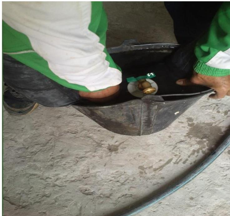
**Figure IV.12** : Vérification de l'étanchéité des chambres à air
