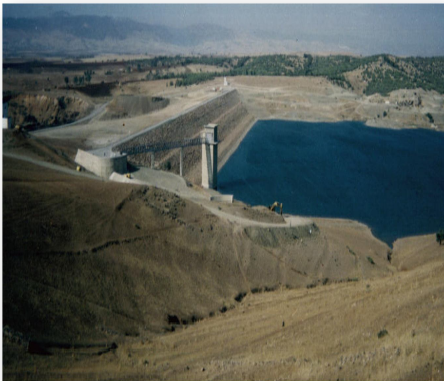
Figure II.1 : Vue du barrage d'Ouled Mellouk (ANBT ,2006)
