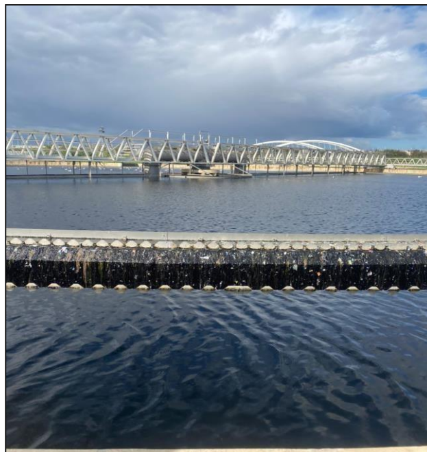
Figure III.4 : Photo du décanteur primaire de la STEP prise par (MAHIZI Anis, 2023)
