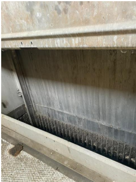
Figure III.2 : Photo des dégrilleurs de la STEP prise par (MAHIZI Anis, 2023).
