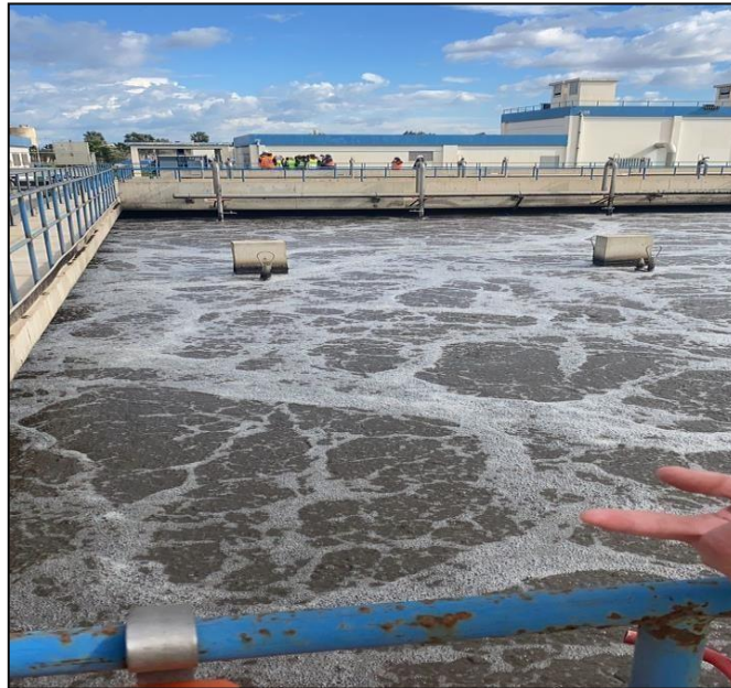
Figure III.5 : Photo du Bassins d'Aération de la STEP prise par (MAHIZI Anis, 2023)
