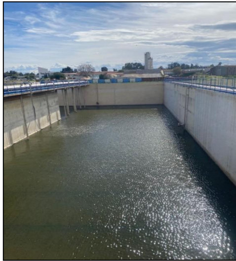
Figure III.7 : filtre à sable de la STEP prise par (MAHIZI Anis, 2023)
