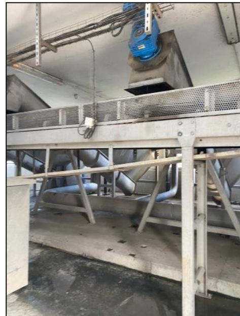
Figure III.2 : Photo des dégrilleurs de la STEP prise par (MAHIZI Anis, 2023).
