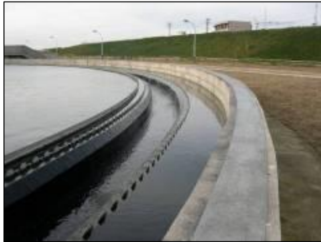
Figure III.10: Photo de Surverse d'un clarificateur (Source : STEP de Beni Messous)
