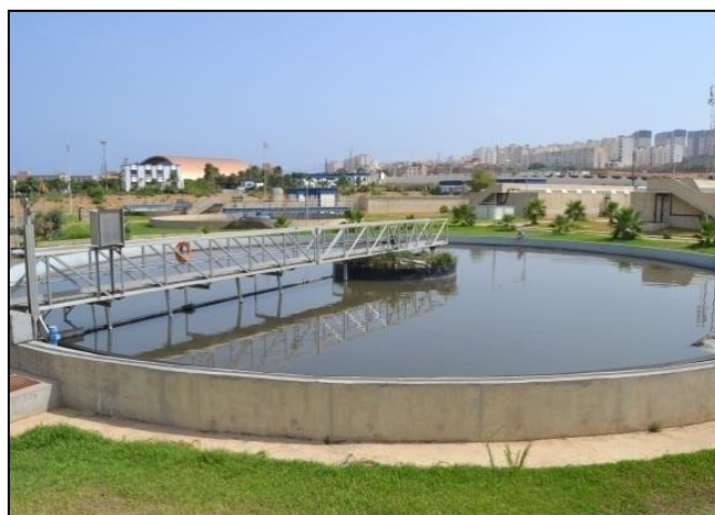
Figure III.7 : Photo du décanteur primaire Tranche 2 (Source : STEP de Beni Messous)
