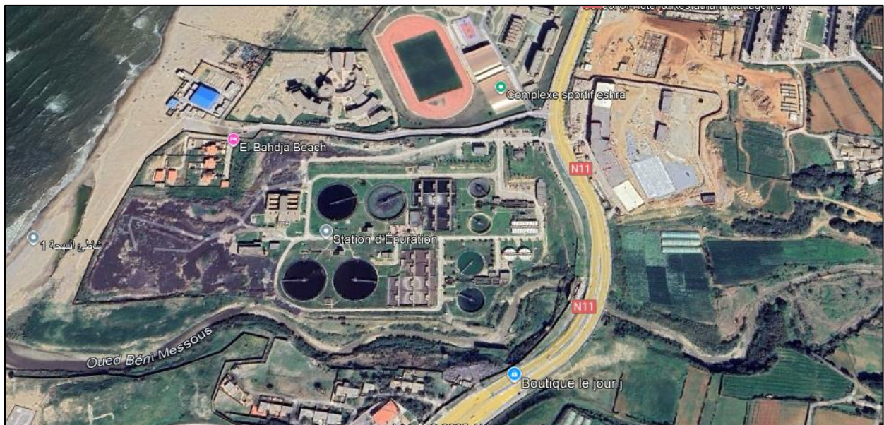
Figure III.1 : Vue satellite de la station d'épuration de Beni Messous (image Google Earth Pro)
