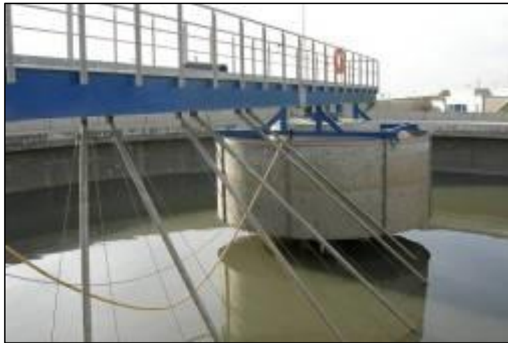
Figure III.6 : Photo du décanteur primaire Tranche 1 (Source : STEP de Beni Messous)
