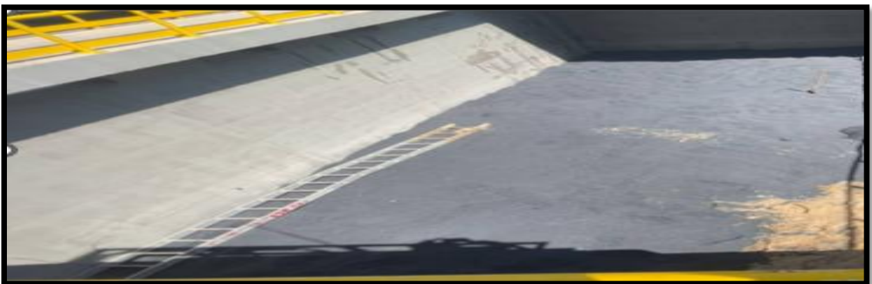
FigureIII.15 - Les couches de filtre à sable
