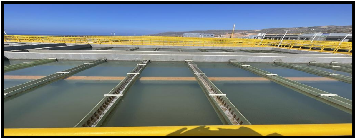
Figure III.13 - Décanteur lamellaire
