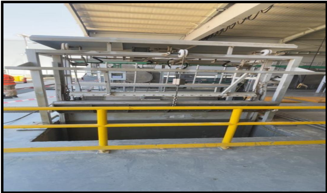
Figure III.8 - Le dégrilleur
