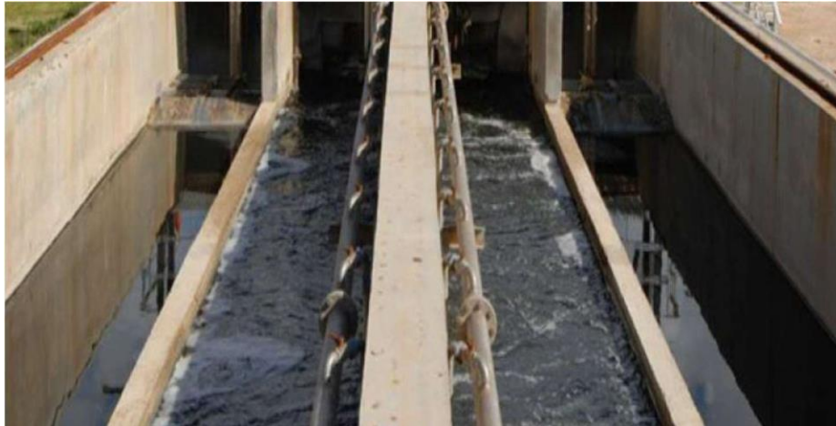
Figure II.4 : Dispositif de dessablage et de déshuilage
