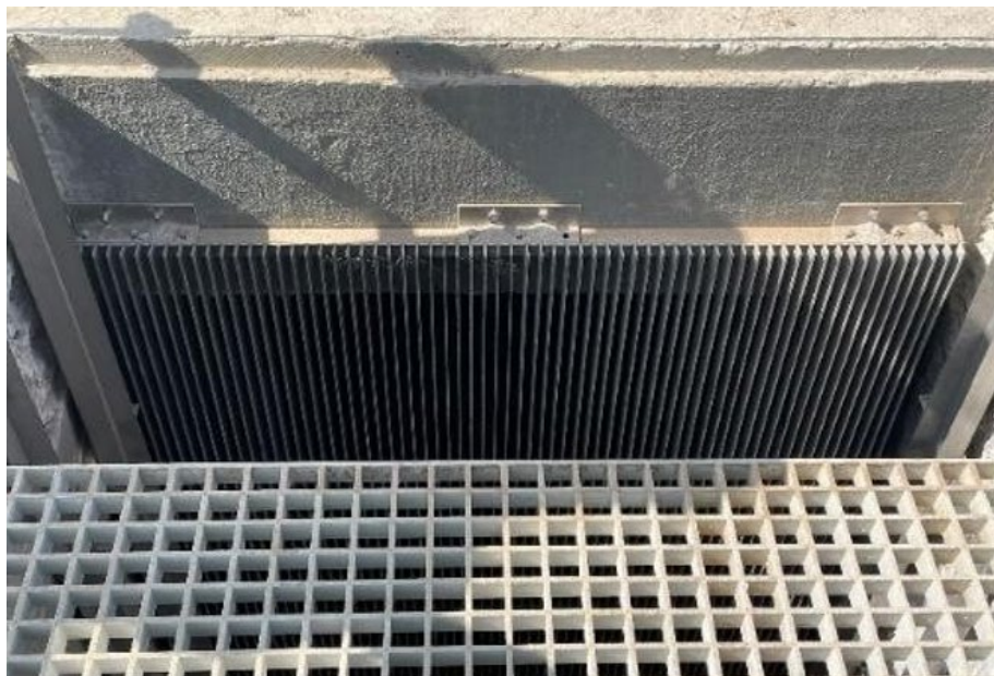
Figure 12: Dégrilleur
