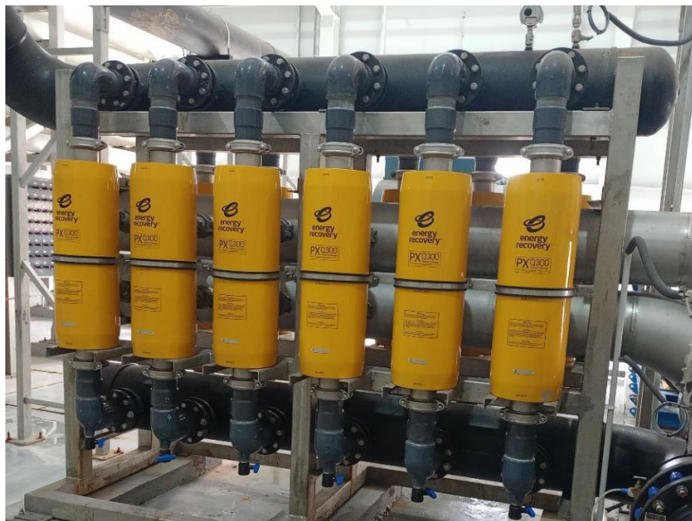
Figure 22: Échangeurs de pression (élaboré par l'étudiante)
