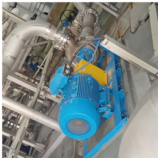
Figure 21: Pompes à haute pression (élaboré par l'étudiante)
