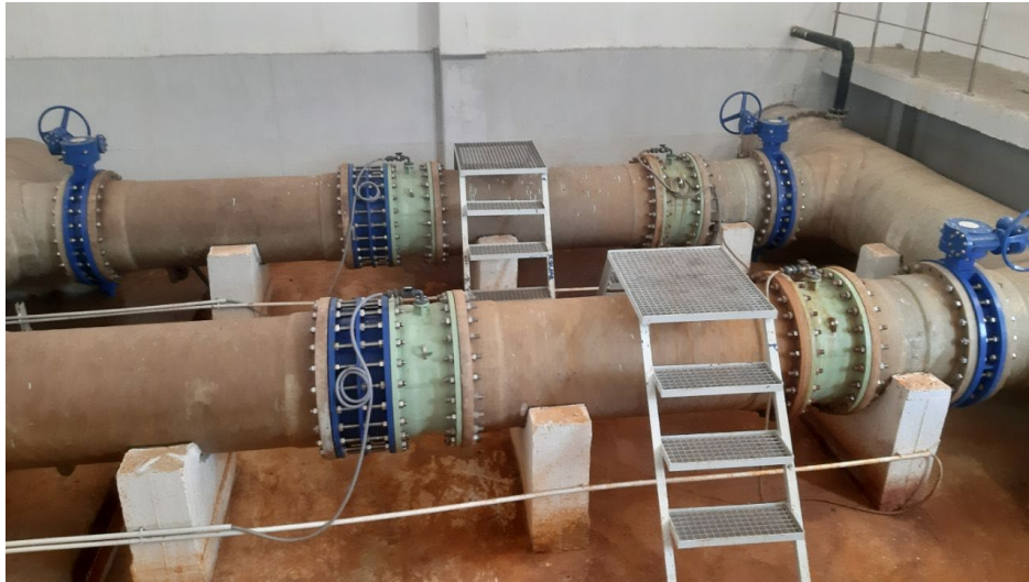
Figure 15: Le mélangeur statique
