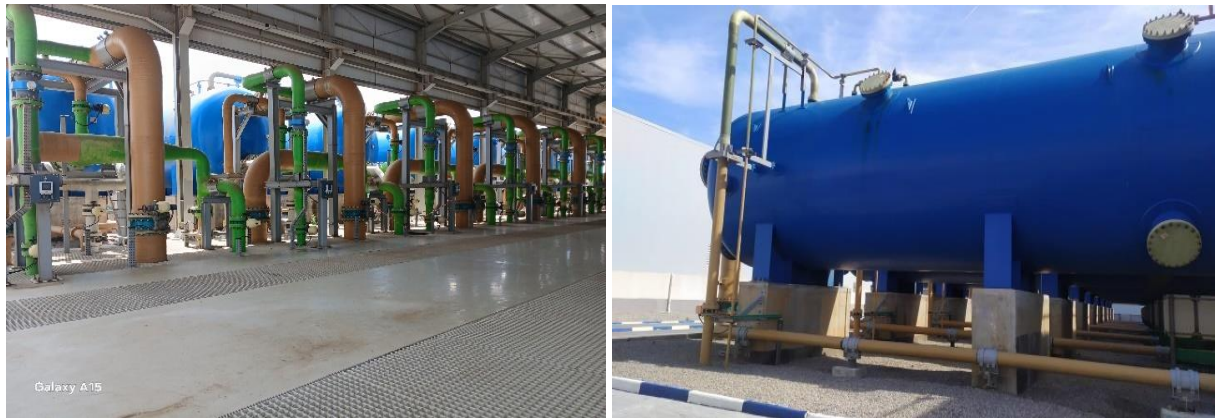
Figure IV. 10 : Filtre à sable
