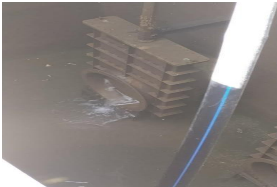
Figure IV. 4 : La vanne d'isolement de la bâche d'admission
