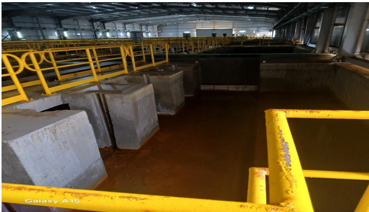
Figure IV. 9 : Décanteur lamellaire
