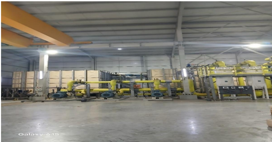
Figure IV. 15 : Système de CIP
