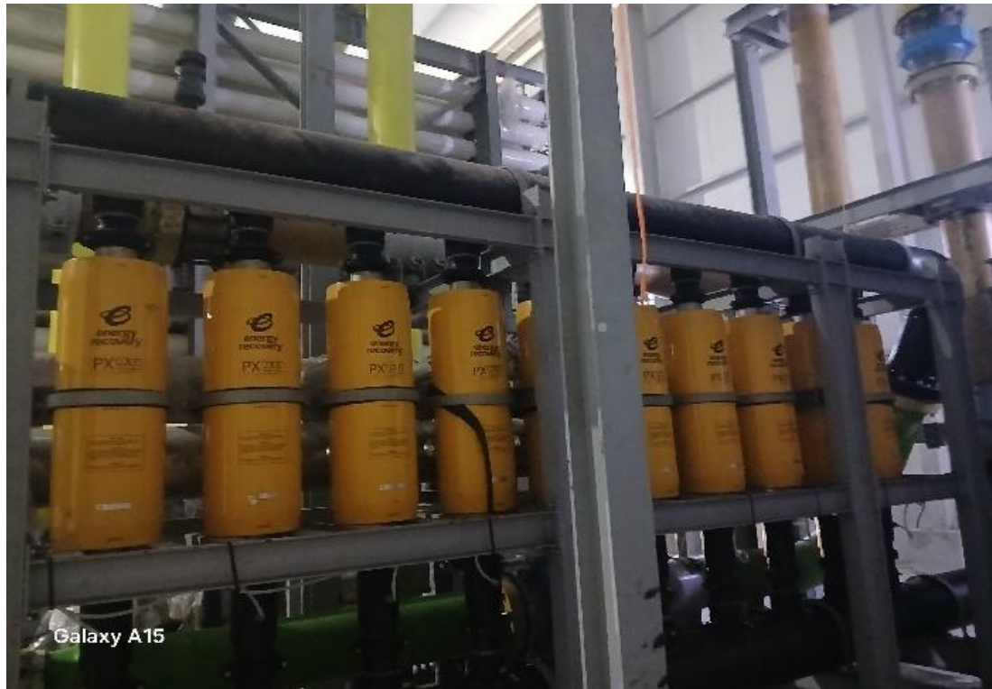
Figure IV. 14 : Echangeur de pression ERI
