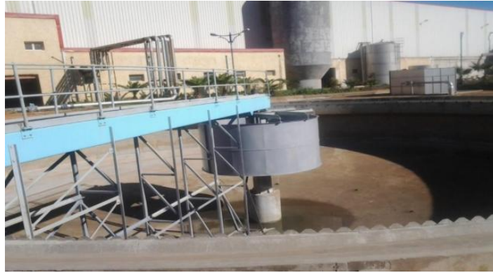
Figure I.6 décanteur primaire de STEP Tonic
