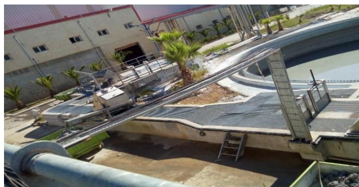
Figure I.3 dégrilleur en escalier de STEP Tonic
