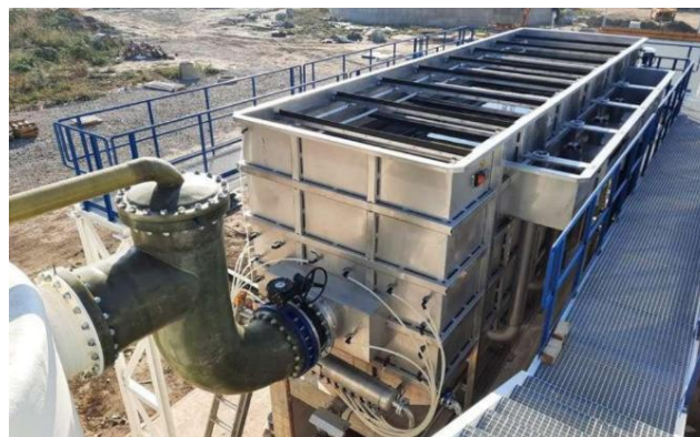
Figure I.5 flotteur de STEP Tonic
