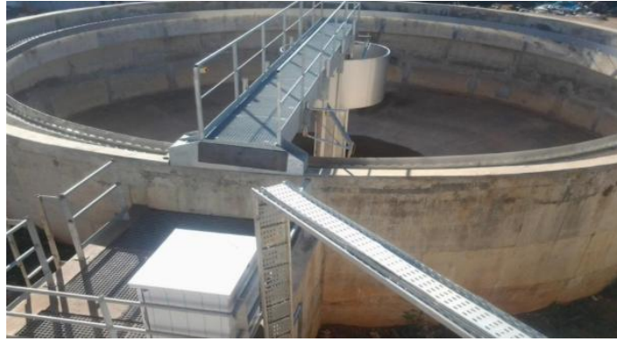
Figure I.10 décanteur secondaire de STEP Tonic
