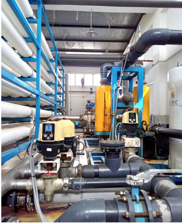
Figure III.15 : Système de récupération d'énergie
