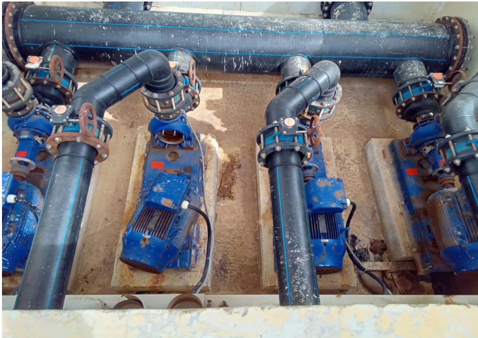
Figure III.12 : Système de pompe haute pression
