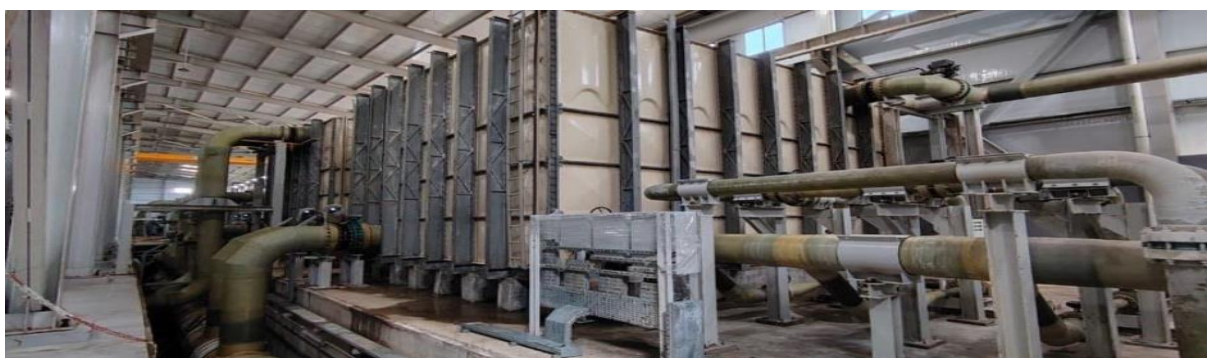
Figure V 47 : photo du réservoir de produit chimique
