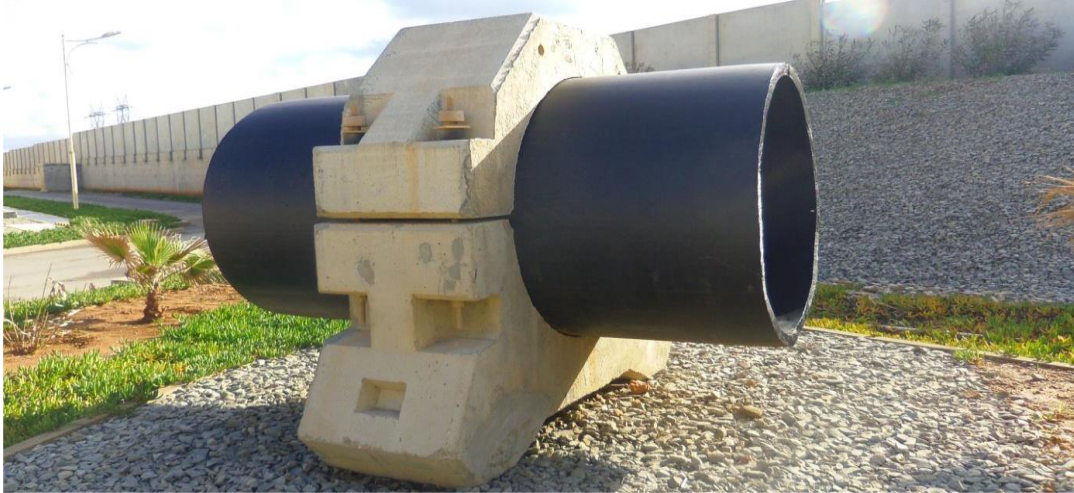
Figure III.18 : Conduite de captage en PEHD.
