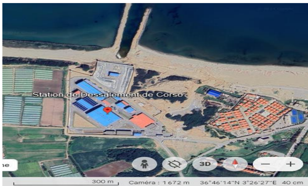
Figure III.16 : photo satellitaire de la station de dessalement d'eau de mer CORSO
