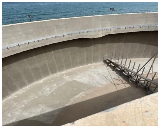
Figure III. 17 : épaississeur de boue
