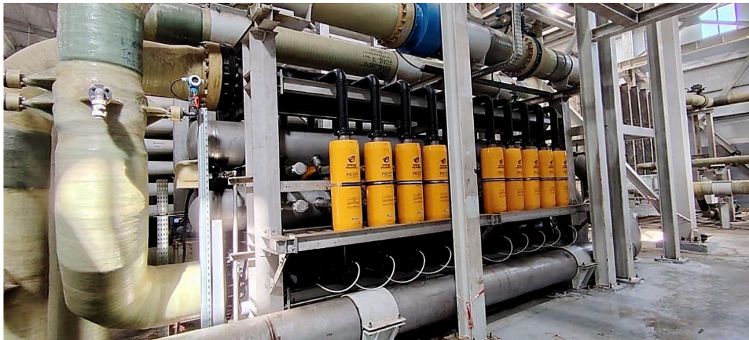
Figure III. 12 : échangeurs de pression PX
