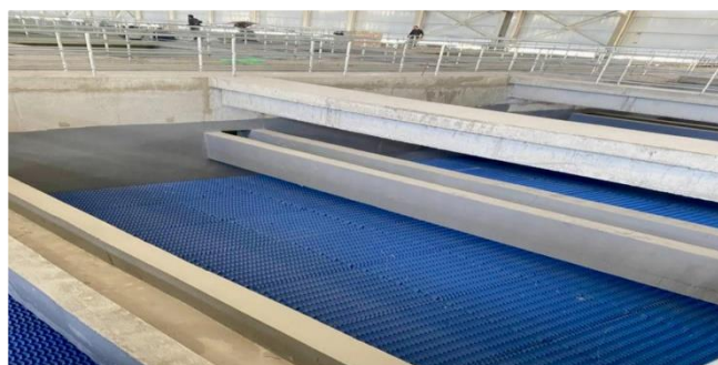
Figure III. 6 : décanteur lamellaire
