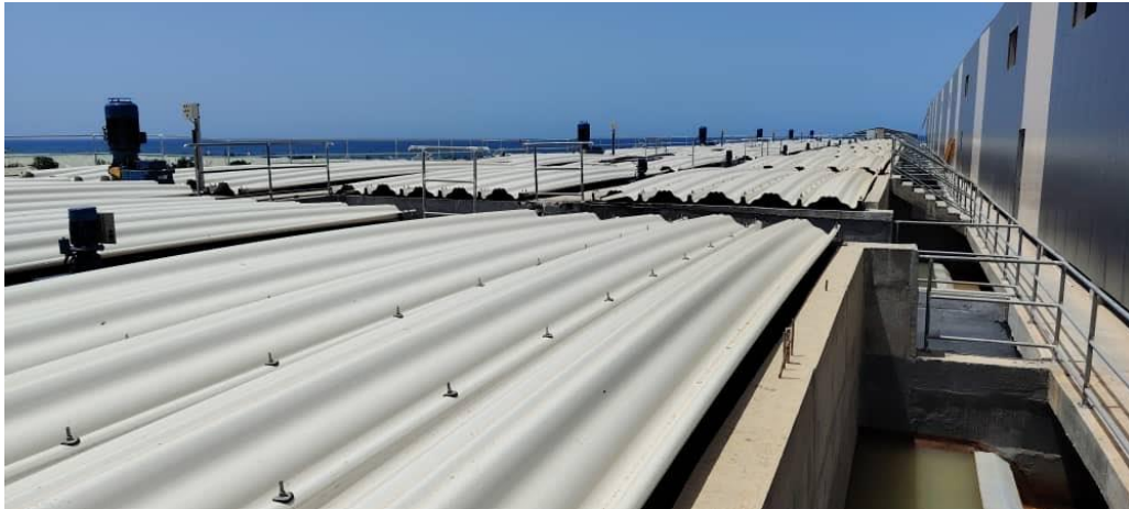
Figure III. 5 : réservoirs de coagulation et floculation
