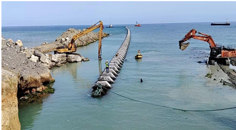
Figure III. 3 : conduite de prise d'eau
