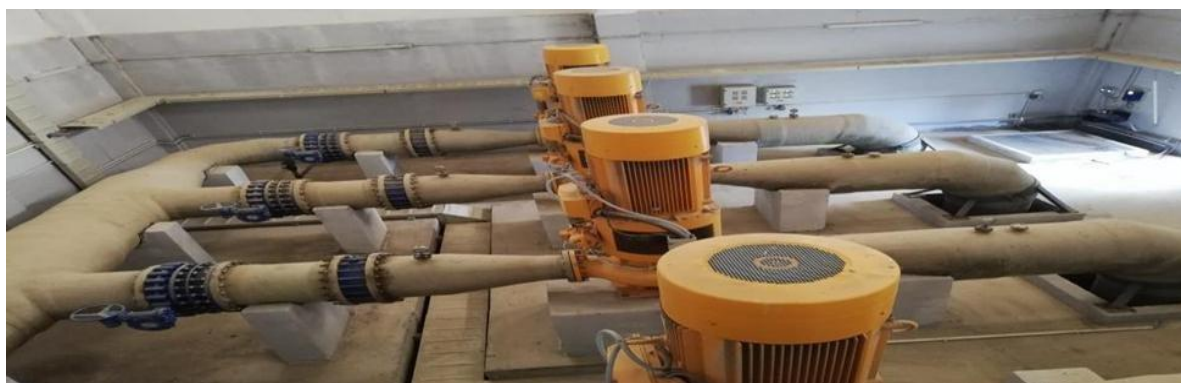
Figure III-3 : Réservoir de pompage (élaboré par l'étudiante)
