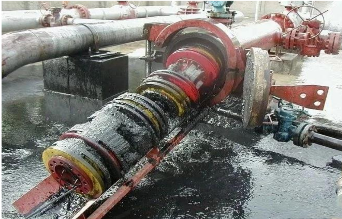
Figure24 : Extraction d'un PIG chargé de dépôts après le nettoyage d'une conduite.[16]
