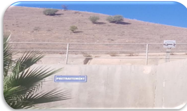
Figure III.6 : Poste de prétraitement
