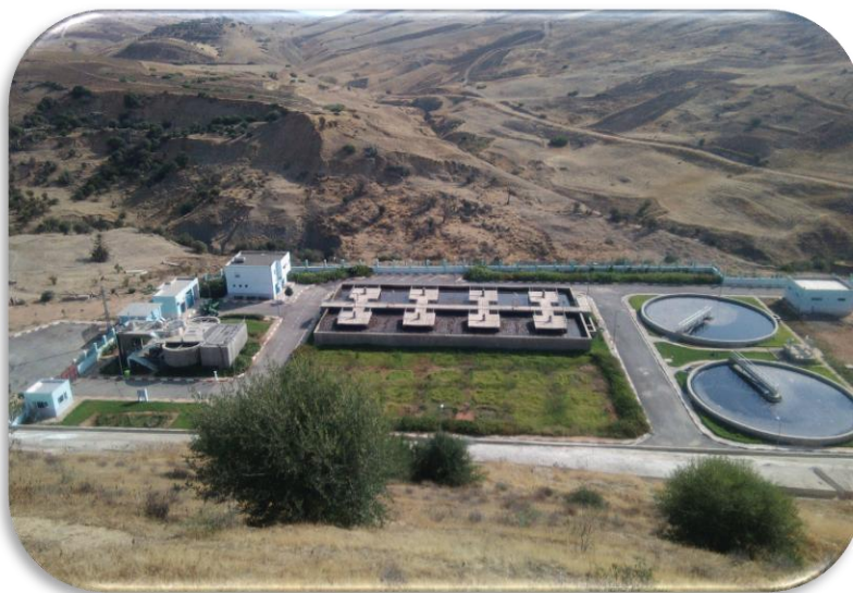
Figure III.4 : La STEP de Mazouna.
