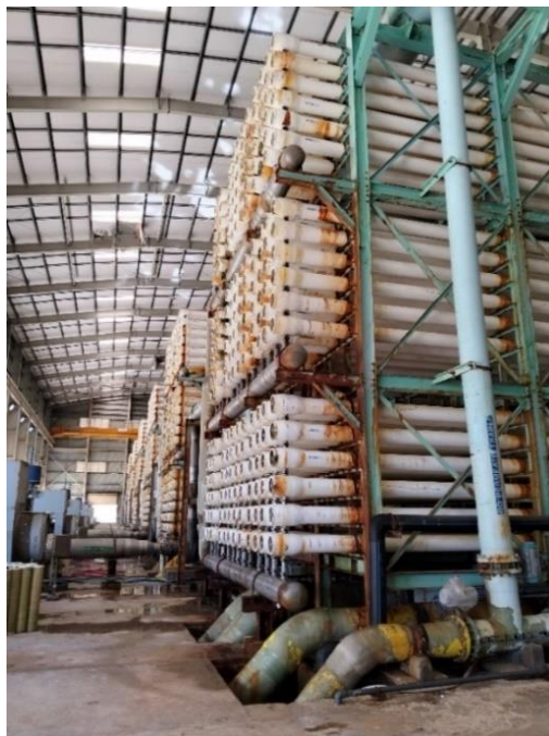
Figure III. 6 : Le system d'Osmose Inverse (RO).
