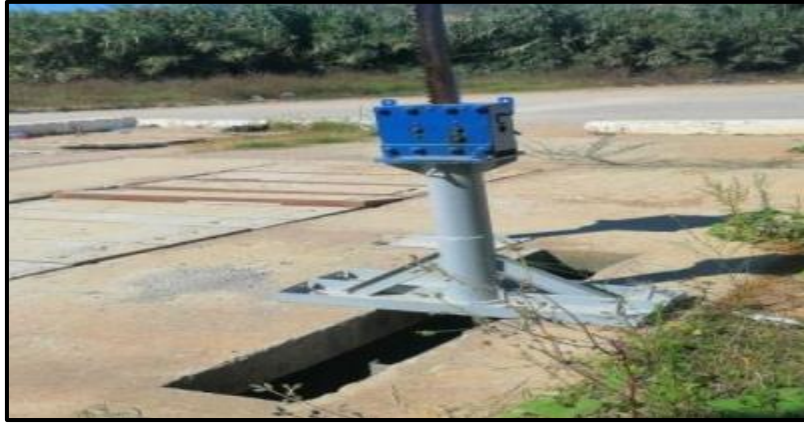
Photo II. 1 : le déversoir d'orage
