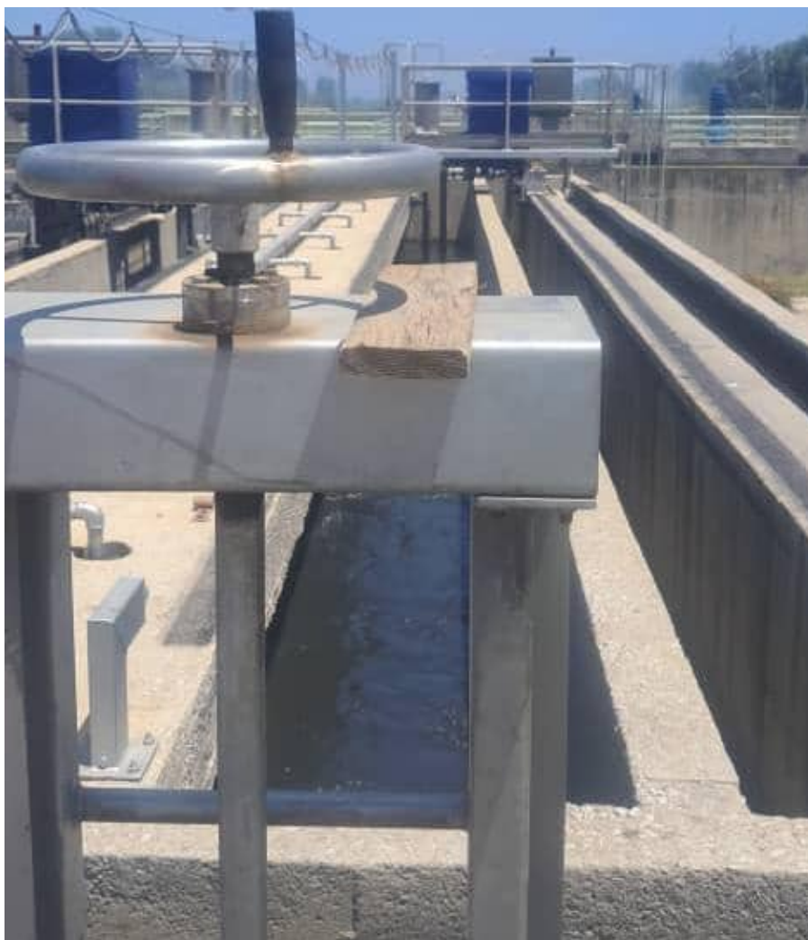
FIGURE 3.3 – Le deshuileur de la STEP de SET ( Image prise par Thiziri )
