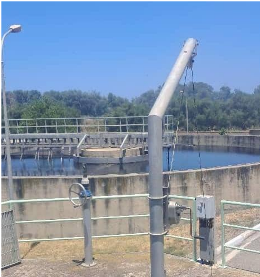
FIGURE 3.5 – Décanteur secondaire de la STEP de Souk-El-Tenine (photo prise par Thiziri)
