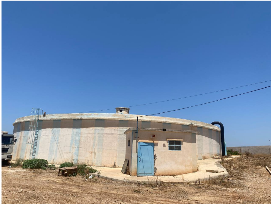
Fig. VII.2 – réservoir existant de Haouch Errih 5000 m 3
