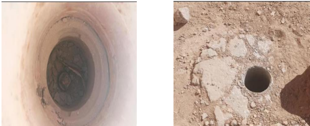
Figure III.24 : Vue sur deux vannes situées dans la partie Est du centre ACL Bouaiche
