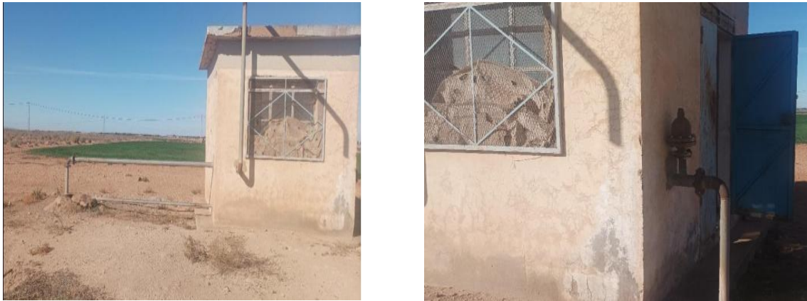
Figure III. 9 : Vue général du forage (2025)
