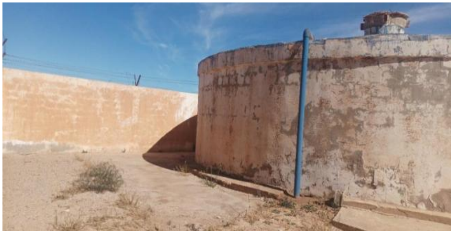
Figure III.15 : Conduite d'arrivée au réservoir R-500m 3
