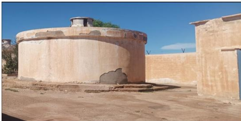
Figure III.17 : Vue générale sur le réservoir R-250 m 3 « ACL Bouaiche »
