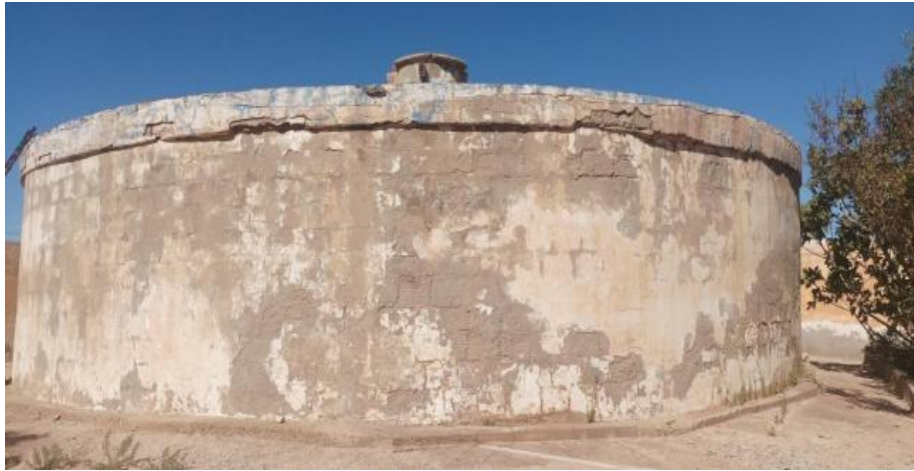
Figure III.14 : Vue générale sur le réservoir R-500 m 3
