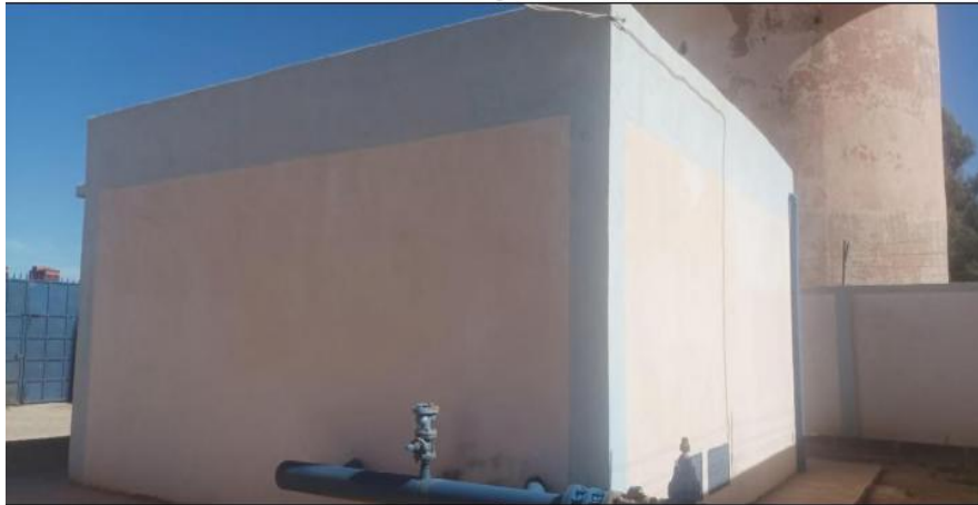
Figure III.20 : Vue sur la station de pompage Chahbounia vers Bouaiche
