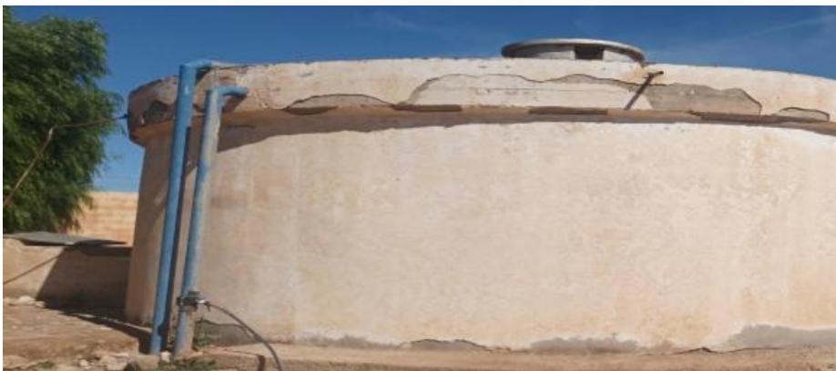
Figure III.19 : Conduites d'arrivées au réservoir R-250m 3 « ACL Bouaiche »
