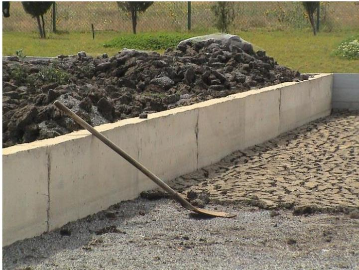
**Figure I.11** : lit de séchage de boues
