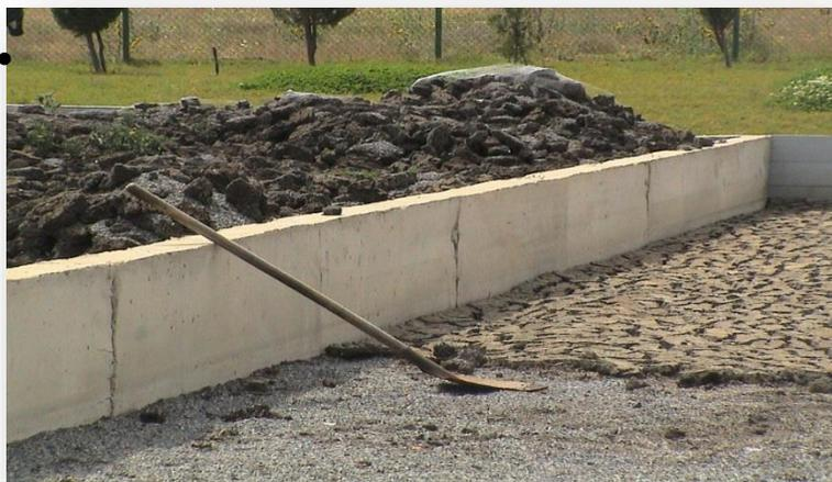
Figure III.4 : Lit de séchage
