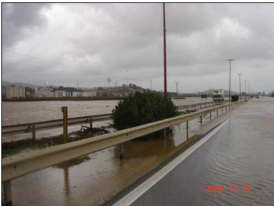
Figure I-9 : Inondation du 13 au 14/12/2005 (Entrée Ouest - RN 44 et Cité Rym) (Source : Protection civile, 2005)
