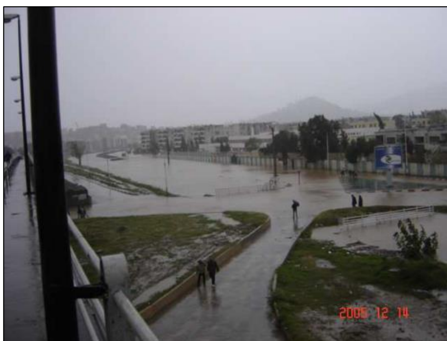
Figure I-7 : Inondation du 13 au 14/12/2005 (Plaine Ouest - débordement du canal de ceinture) (Source : Protection civile, 2005)
