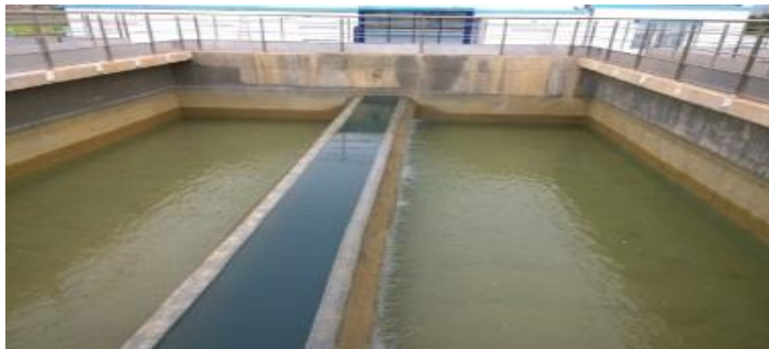
Figure 28 : Bassin de filtre à sable [29]
