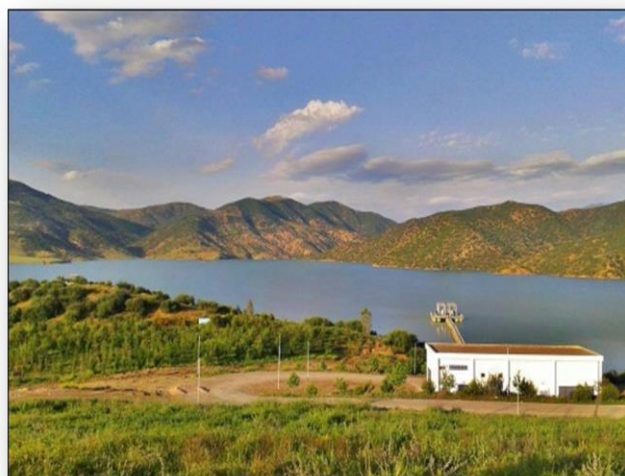
Barrage Sidi M'hamed Ben Taiba
