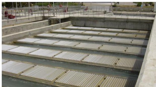
Figure 27 : Bassin de décanteur lamellaire [29]
