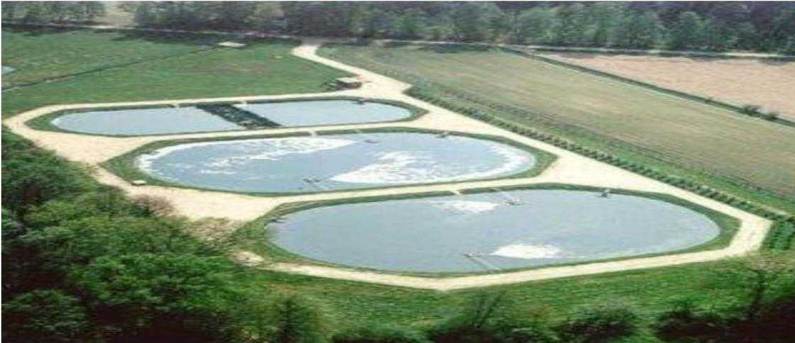
**Figure III.8 Lagunage aéré**
