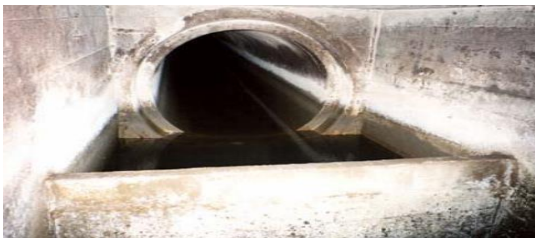
Figure VI-8 : Exemples de déversoir frontal
