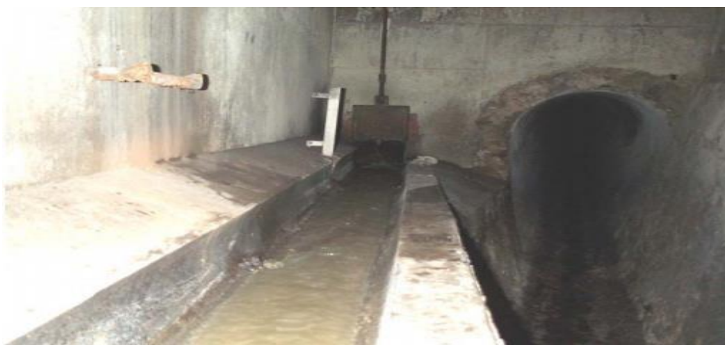
Figure VI-9 : Exemple de déversoir à seuil latéral
