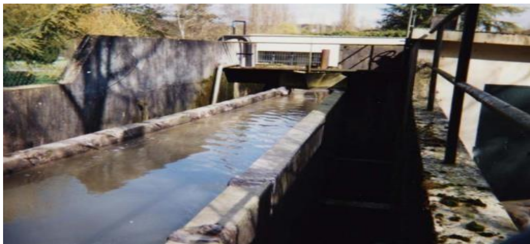
Figure VI-10 : Exemple de déversoir à double seuil
