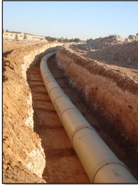
Figure VII.31 : Mise en place des canalisations
