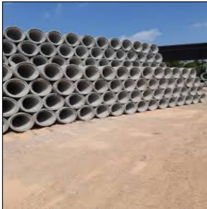
Figure VII.29 : Stockage de collecteurs
