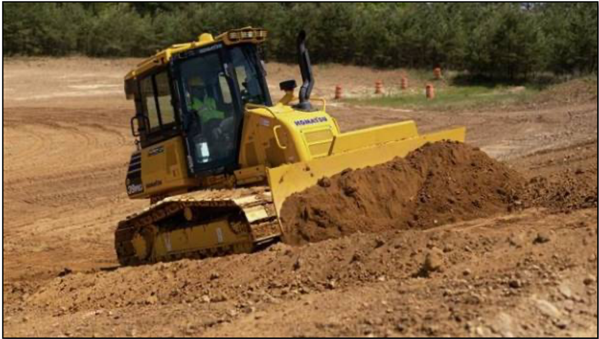
Figure VII.30 : Décapage par bulldozer
