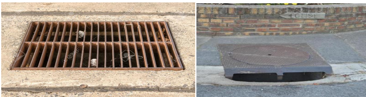
Figures VII.2. Exemples de bouches d'égout par absorption verticale et absorption latérale(google)
