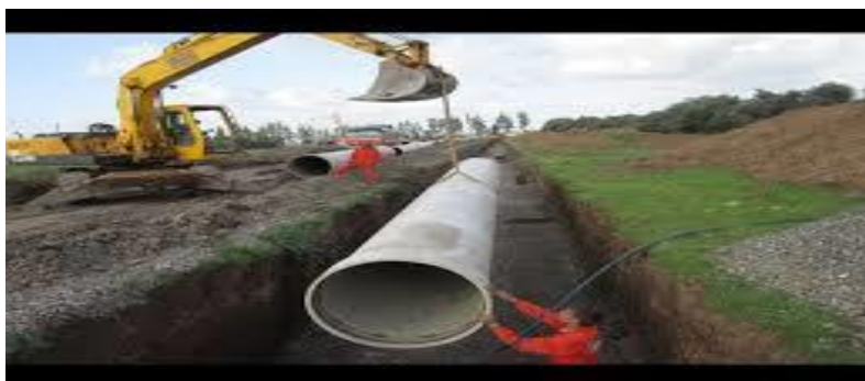
Figures VIII. 3 : mise en place des canalisations
