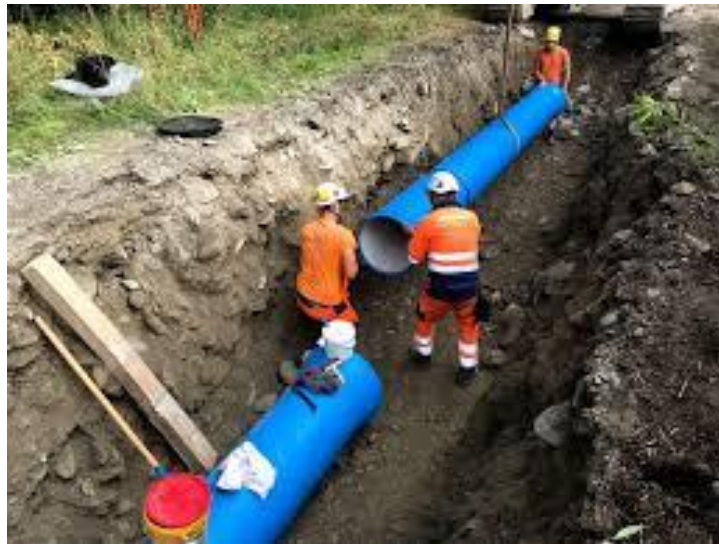
Figure VIII. 2 : mise en place des conduites
