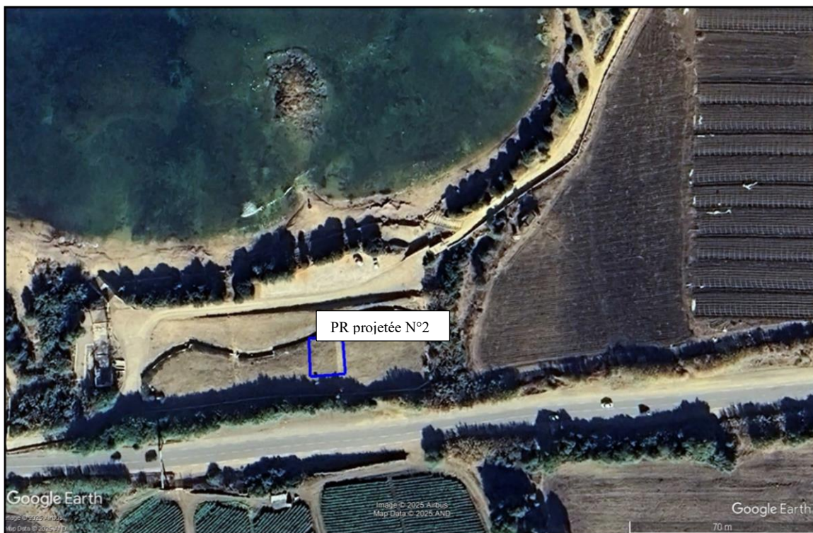
Figure VII. 8: emplacement de deuxième station de pompage (image satellite non traitée, 2025)
