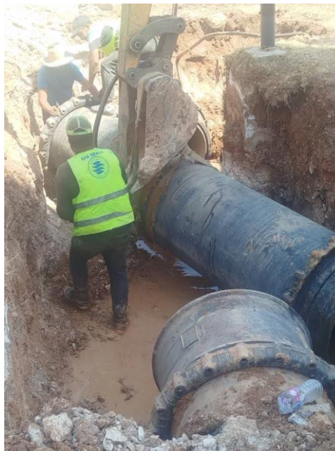
Figure VII.2: Pose de la canalisation sur terrain
