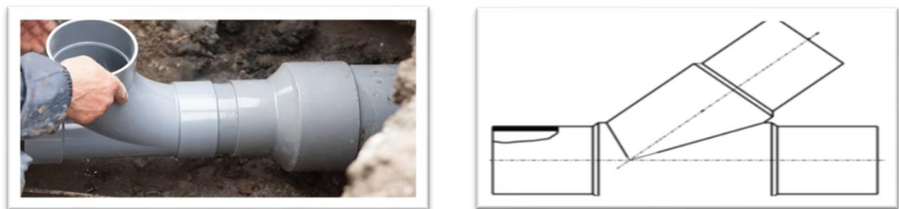
Figure (VI-15) : Exemple d'un branchement simple.
