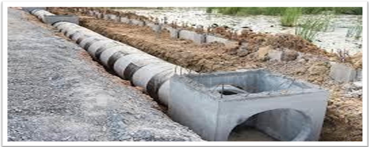
Figure (VII8) : Assemblage des conduites.
