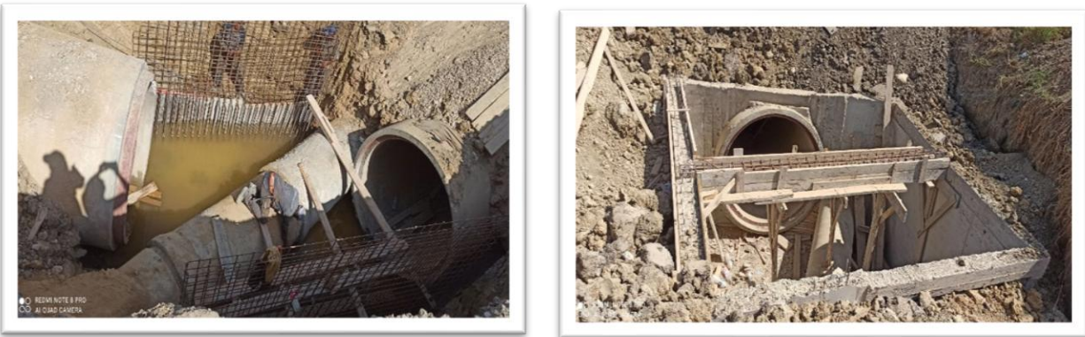
Figure (VII-5) : Réalisation d'un regard.
