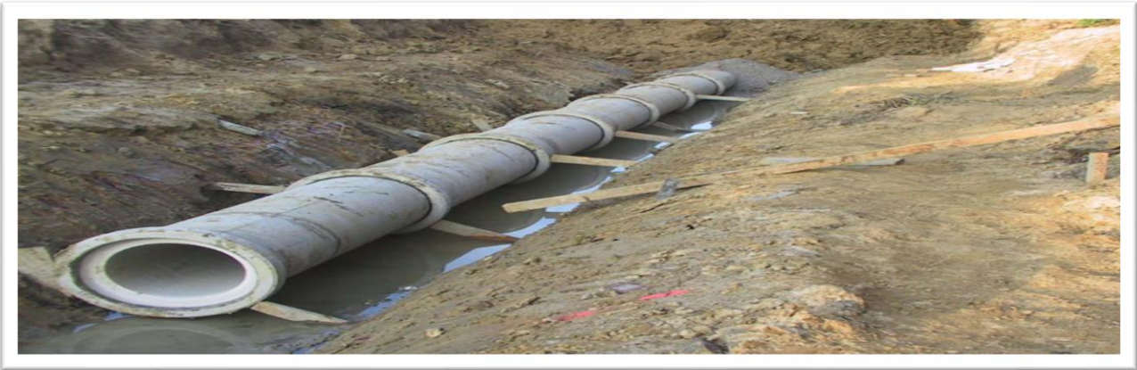
Figure (VI-2) : conduites en béton non armé.
