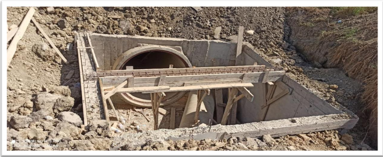
Figure (VII-9) : Regard au cours de réalisation.
