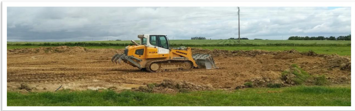
Figure (VII-4) : Décapage de la couche de terre végétale.
