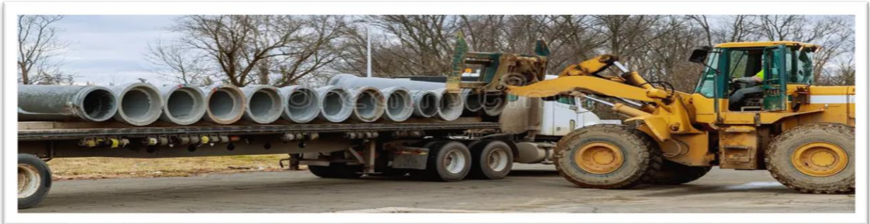
Figure (VII-2) : déchargement des canalisations.
