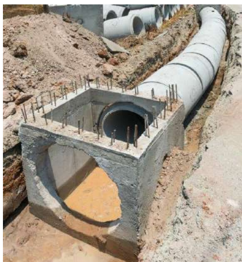
Figure VII.1 : Assemblage des conduites
