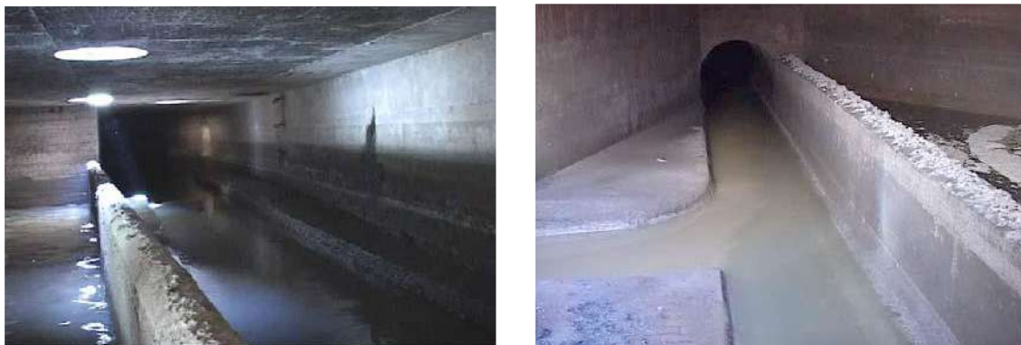
Figure VI.8 : Déversoir d'orage latéral
