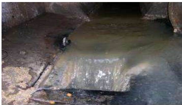
Figure VI.11 : Déversoir à orifice
