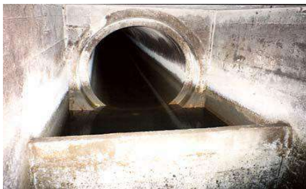
Figure VI.10 : Déversoir d'orage frontal
