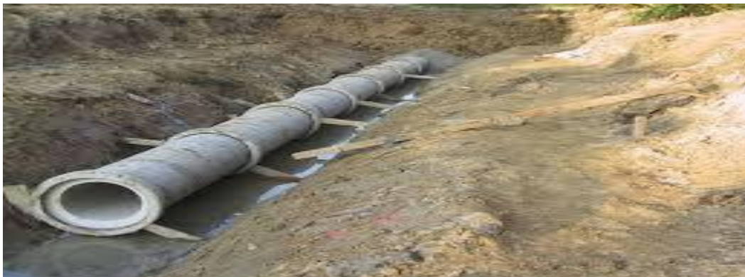
Figure VII- 1 : Conduite en beton non armé (Source : ArchiExpo, 10/04/2025)
