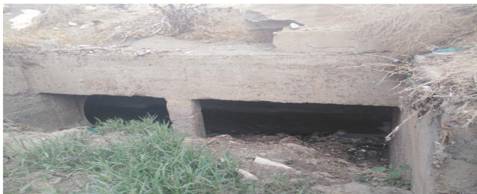
Figure II - 9 : Vue extérieure du déversoir d'orage
