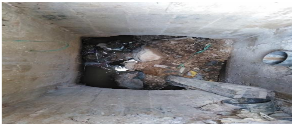
Figure II - 4 : Regard rempli par les déchets (DRE Tiaret 2025).
