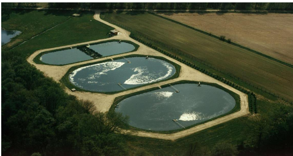
Figure II-4 : photo d'un lagunage aéré.
