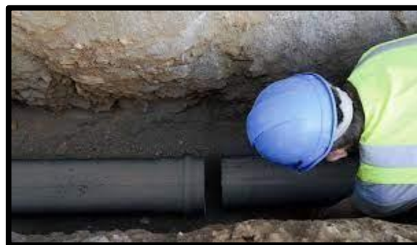
Figure VI-34 : Assemblage des conduites
