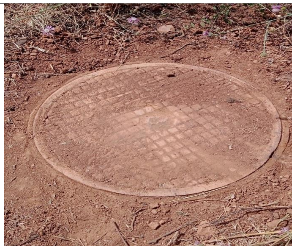
Figure V.4 : Tampon fermé par clé.
