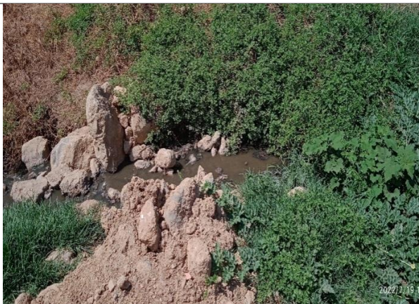
Figure V.1 : Regard qui déborde recouvert par la végétation et les terres.
