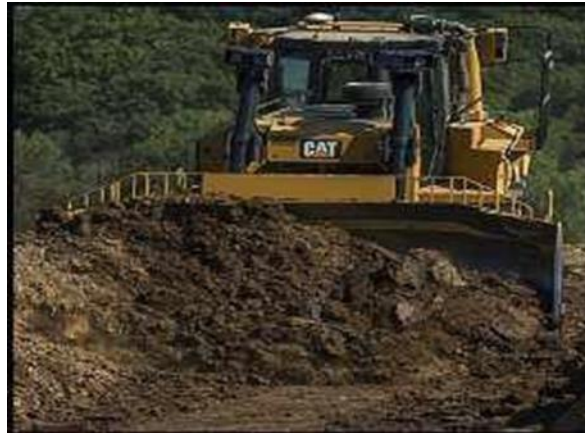
Figure VIII.2 : Décapage par bulldozer
