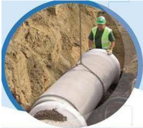
Figure VIII.3 : Mise en place des canalisations
