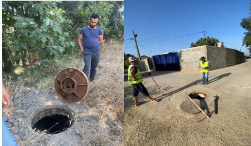
Figure III.2: Inspection détaillée des regards
