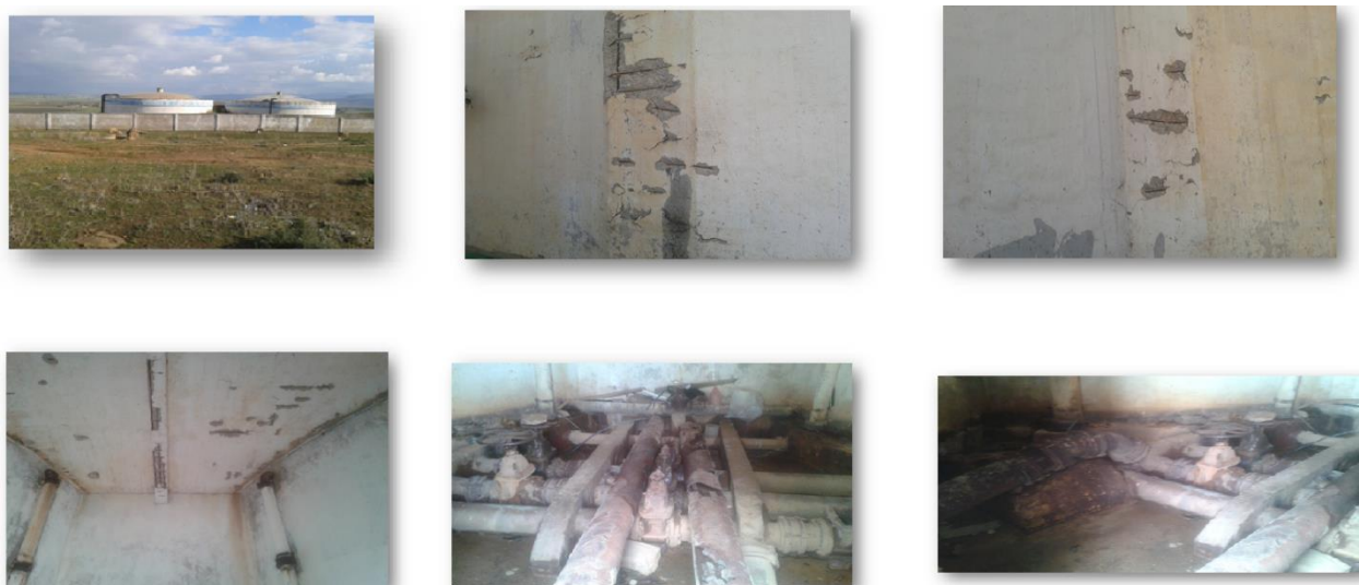
Figure III.3 : état de Le réservoir 2*1000M3 et des conduites d'amené, vidanges et distribution.
