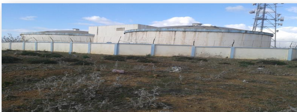
FigureIII.2 : Le réservoir tampon 2*1000M3.
