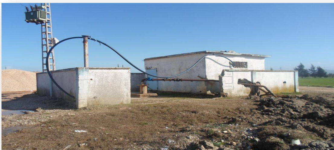
FigureIII.1 : La station de pompage (forage Bellahmar N°02) .
