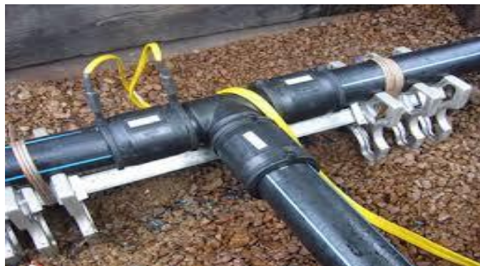
Figure VI.8 : Electrosoudage
