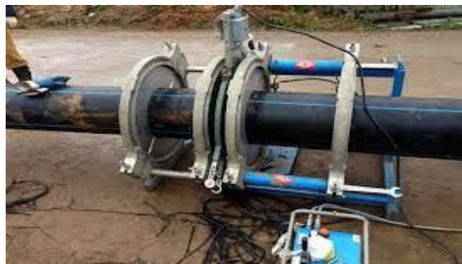
Figure VI.9 : Soudage bout à bout
