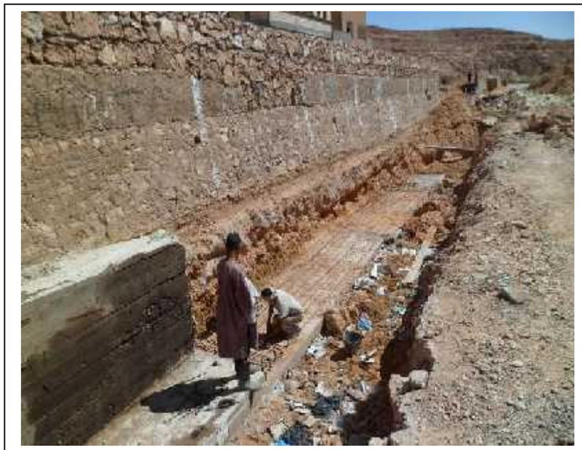
Figure IV -15: Travaux de confortement des voies
