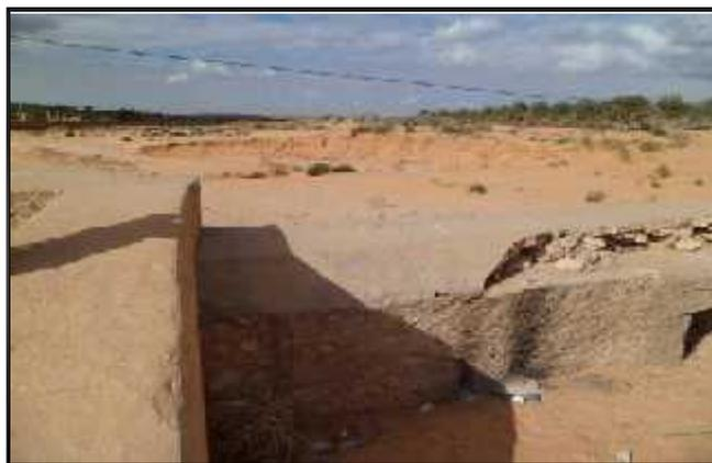
Figure IV -9: Etat dégradé de la digue
