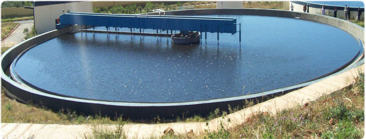
Fig n° III-2 : décanteur secondaire (clarificateur)
