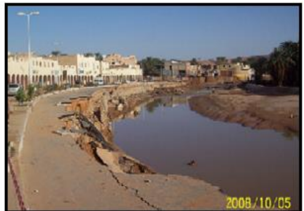
Figure II.14. Dégâts causés par la crue (Bensaha, 2010)
