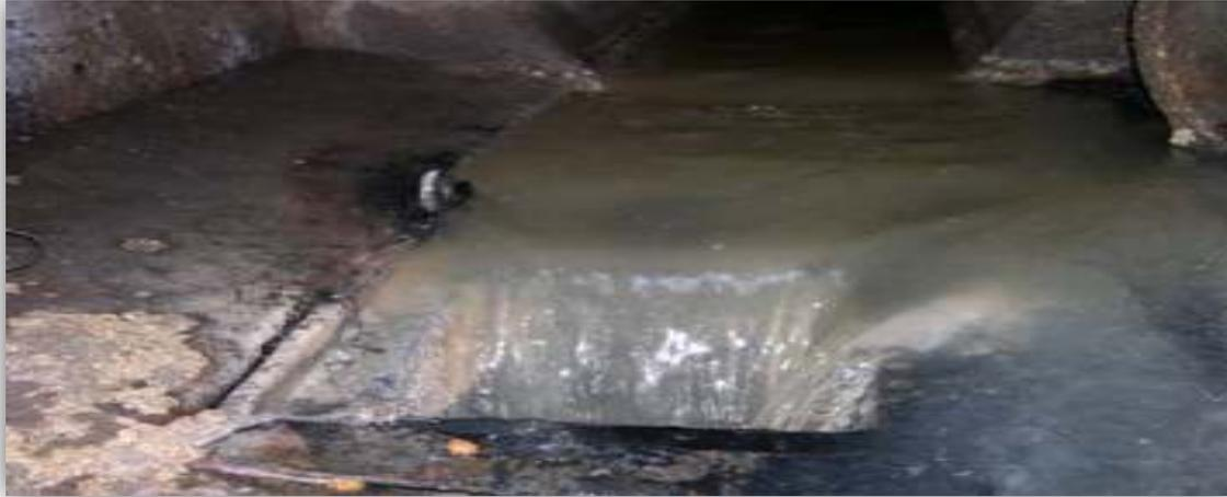
**Figure 6.7 :** exemple de déversoir à ouverture de radier.
