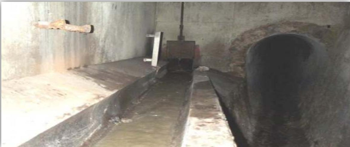
**Figure 6.8:** exemple d'un déversoir à seuil simple.
