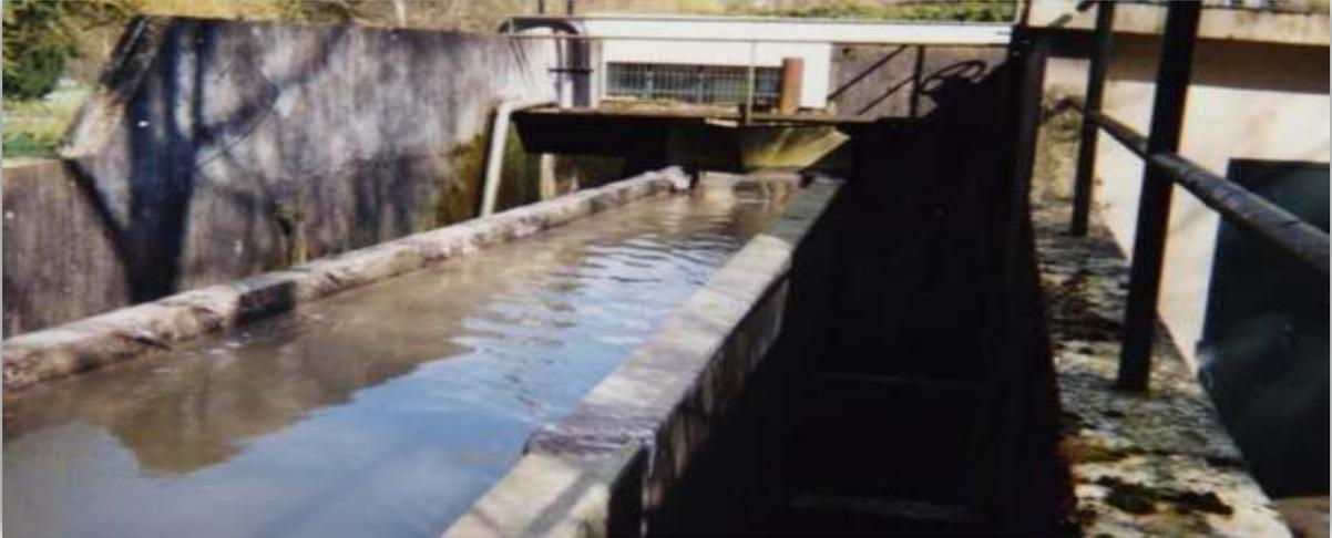
**Figure 6.9** : exemple d'un déversoir à seuil double.
