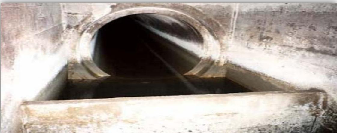
**Figure 6.10** : exemple d'un déversoir à seuil frontal.
