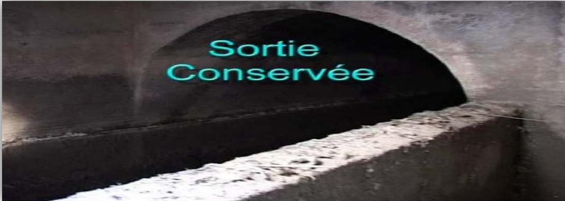
**Figure 6.11** : exemple d'un déversoir à seuil bas.
