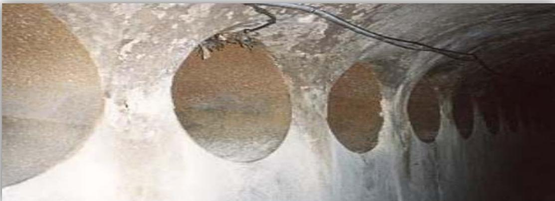
**Figure 6.6** : exemple de déversoir à trou.
