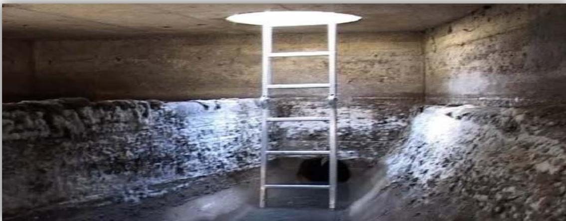
**Figure 6.12:** exemple d'un déversoir à seuil haut.
