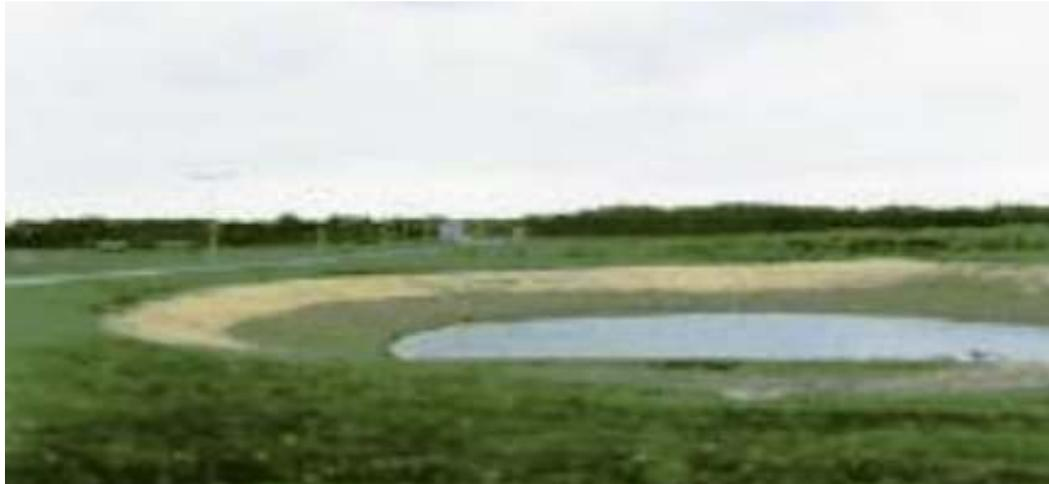
**Figure 6.1.3** : exemple d'un bassin de retenue sec dans une cuvette naturelle.
