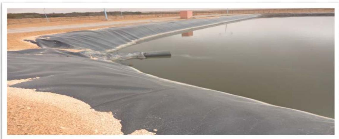
**Figure.2.2.**Bassin revêtu en Géo-membrane.
