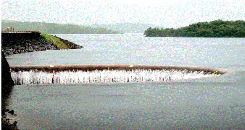
**Figure III.1** Déversoir de type Bec de Canard du barrage Salaulim, Inde
