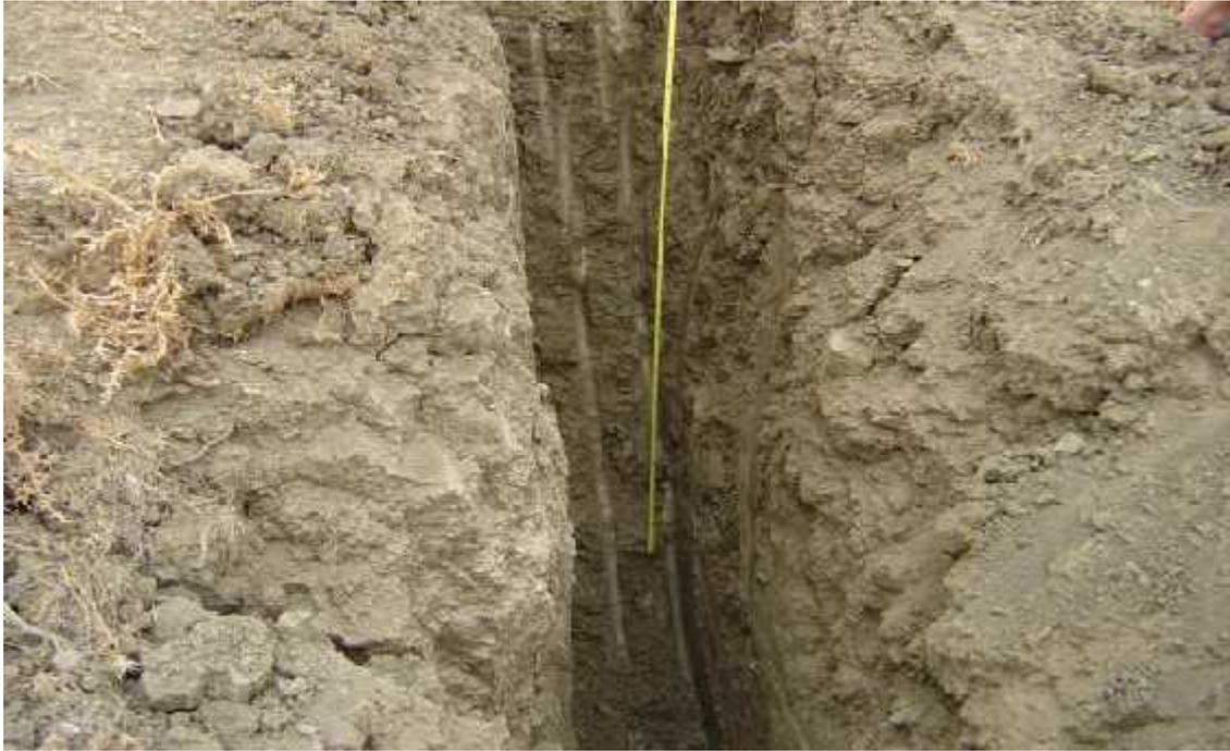
**Photo 5 :** Une fouille montrant des marnes noires de plus de 2,5 m d'épaisseur.
