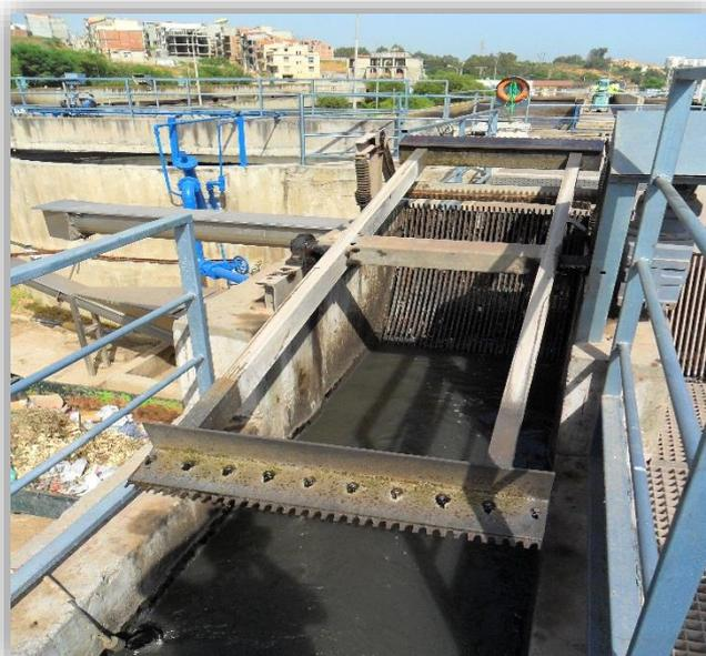
*Figure III.05 : Dégrilleur (20 mm)*
