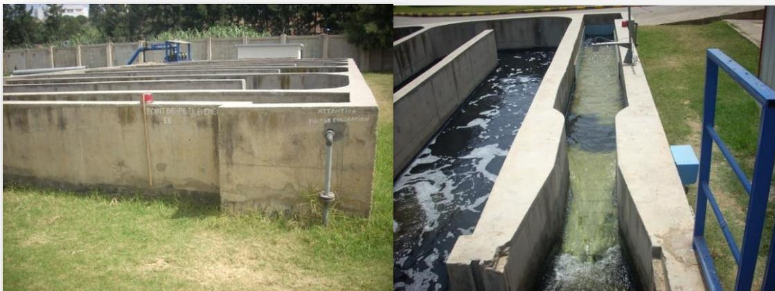
Figure III.11 : Ouvrage de désinfection
