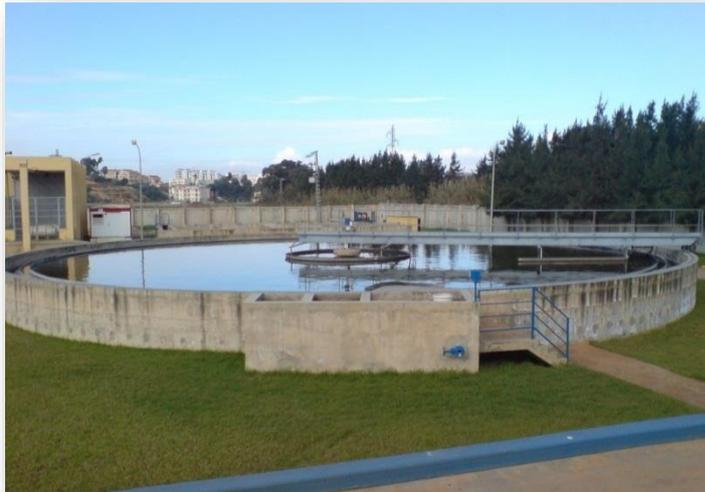
Figure III.10 : Décanteur secondaire-Clarificateur
