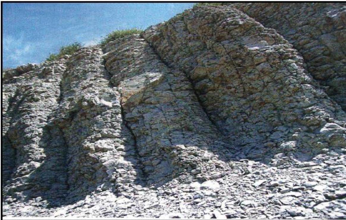
**Appui rive gauche, alternance des joints fermés et ouverts**
