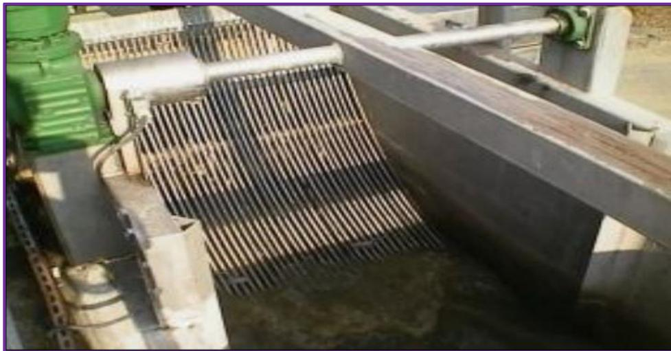
Figure III.4 : Grille mécanique courbe
