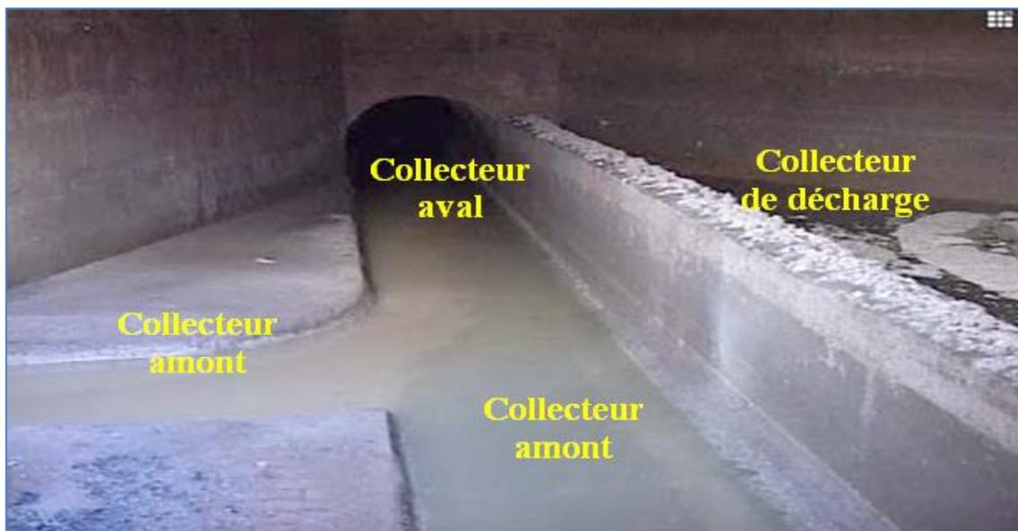
Figure V.1 : Modèle de déversoir d'orage
