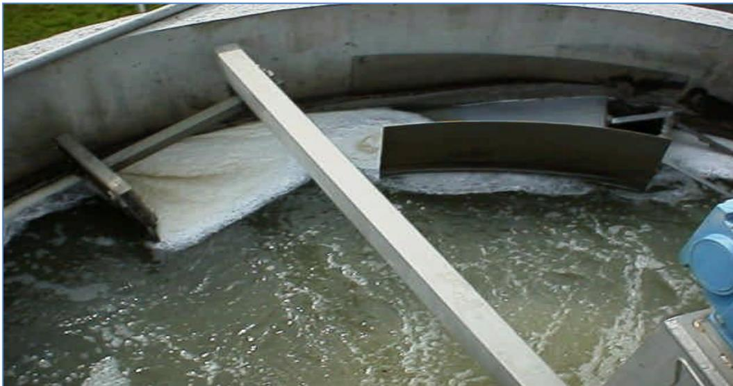
Figure III.6 : Racleur des graisses d'un dessableur- dégraisseur
