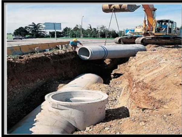
Figure VII.6- pose de conduite avec une pelle
