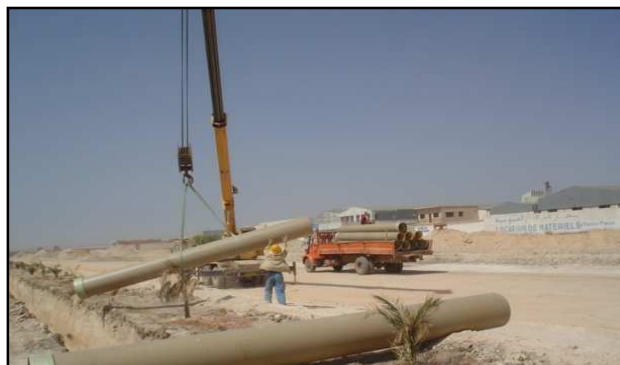
Figure 9.6 : Mise en place des conduites
