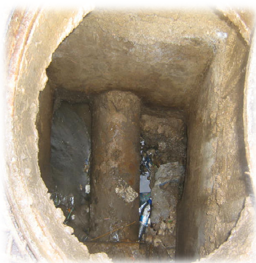
Conduite des EU traversant
