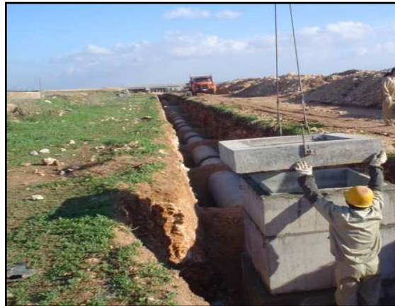
Figure 9.3 : Un schéma d'un regard à construire
